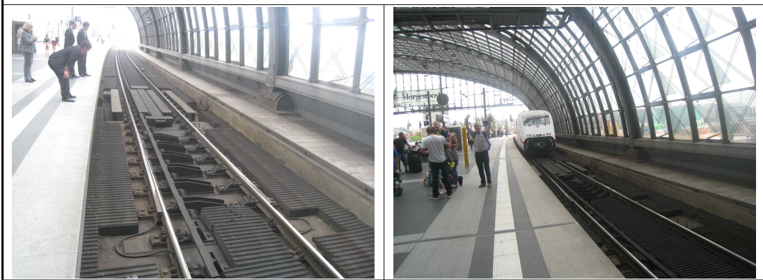
신축이음장치 및 ERL체결장치 부설현장 확인 (베를린 중앙역)
