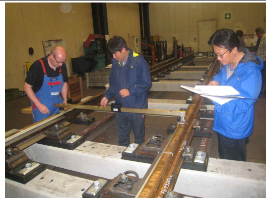
신축 조립 검사
