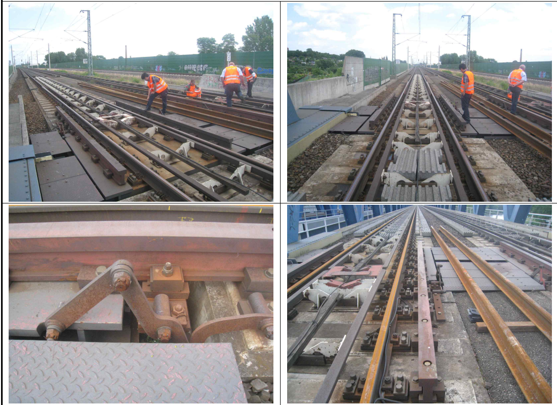
신축이음장치 및 ERL체결장치 부설현장 확인 (하벨교)
